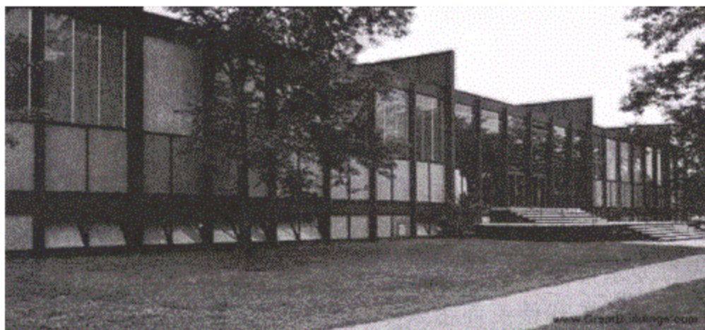
图 7-3 密斯 ( Ludwig Mies Van der Rohe ) 为伊利诺伊理工学院所设计的建筑学系 Crown Hall，使用外部钢梁悬挂结构，建筑内部没有一根柱子，最大程度地提供了可利用的内部空间
